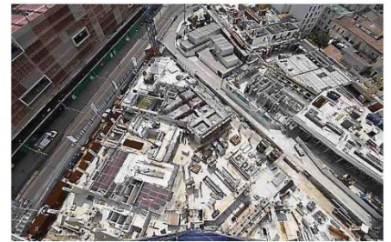
8 mai 2020 : la crise sanitaire a ralenti le chantier. PHOTO TIMELAPSE CO
